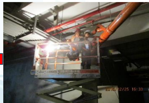
⑥ 大樓內部改管主管線佈設
