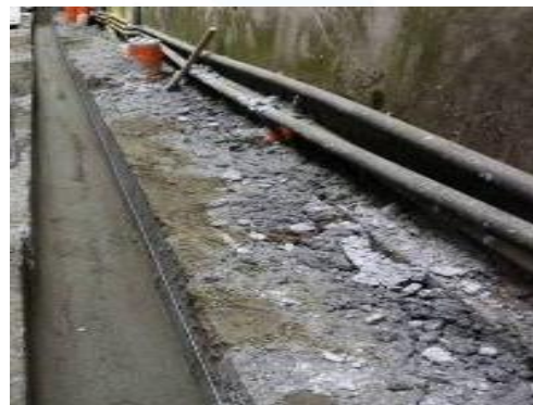
⑪ 新建 雨水溝
