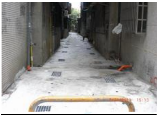
⑫ 施工後後巷 鋪設混凝土地坪
