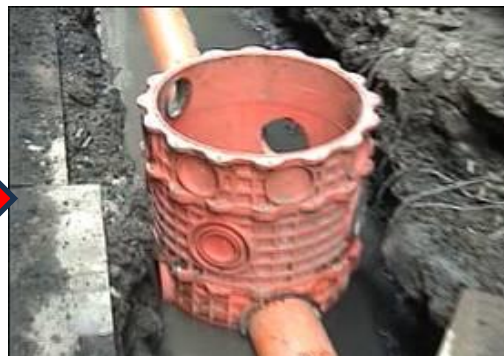
⑧ 後巷開挖 污水設施埋設
