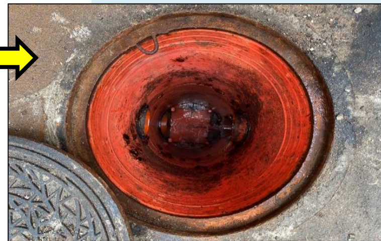
污水管，管內乾淨無阻塞
