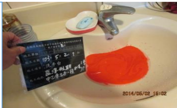
⑦ 雨、污水管投色劑試水確認
