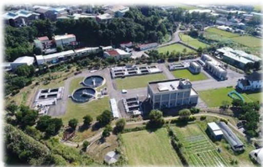
大溪水資源回收中心
