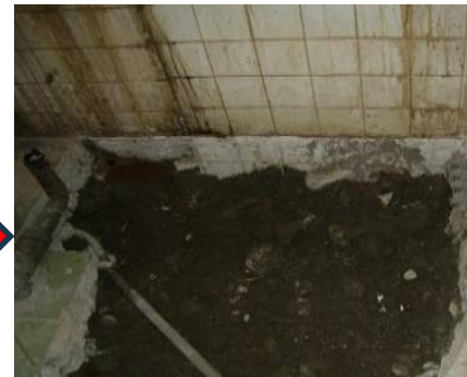
化糞池 接管及填平
