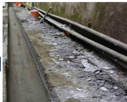
新建 雨水排水溝
