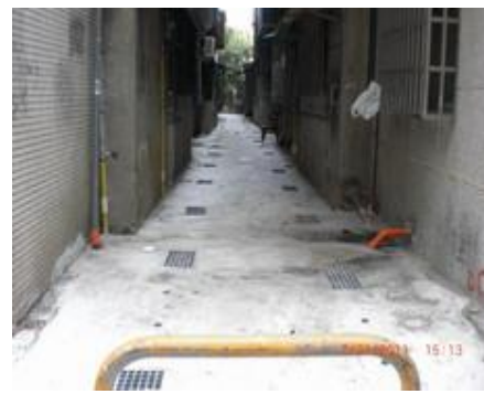
施工後後巷 鋪設混凝土地坪
