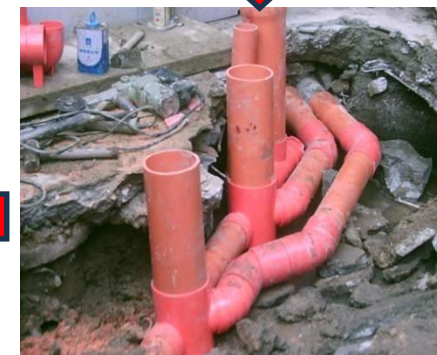
銜接 用戶污水管線
