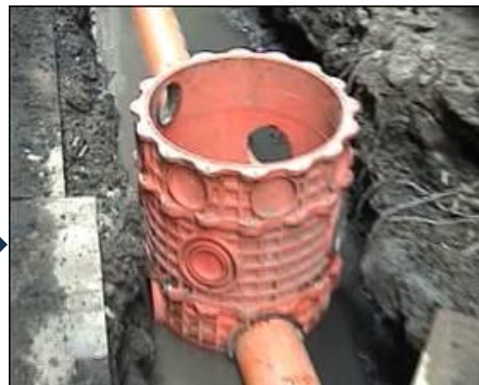
後巷開挖 污水設施埋設
