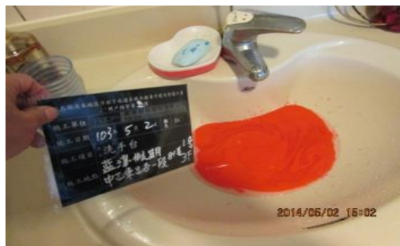
雨、污水管投色劑 試水確認
