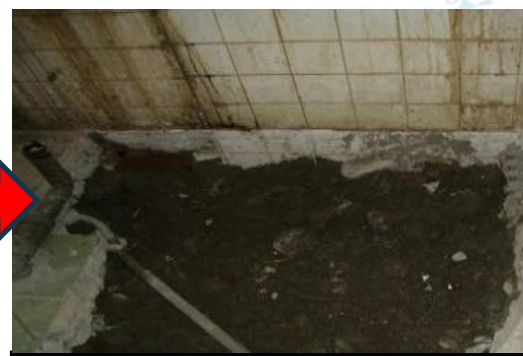
化糞池 接管及填平
