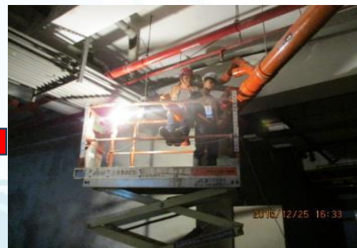
大樓內部改管 主管線佈設
