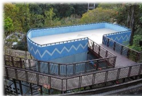
羅浮水資源回收中心
