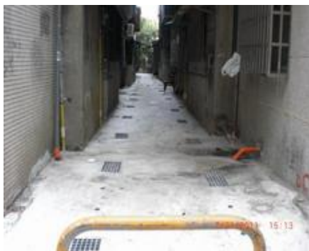
鋪設後巷 混凝土地坪
