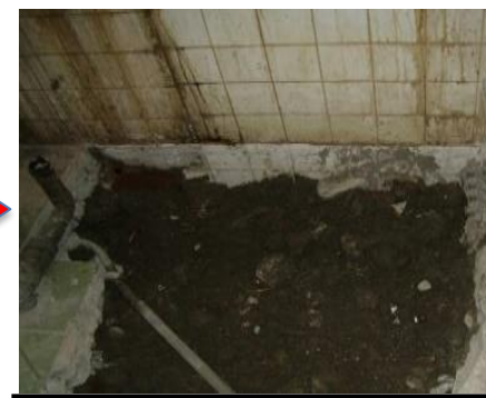
化糞池打除 接管.回填
