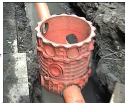
後巷開挖 污水設施埋設
