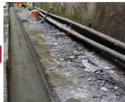
新建 雨水排水溝
