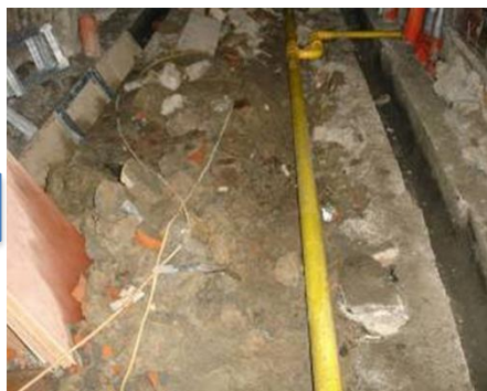
後巷民生管線永遷 (自來水、瓦斯)
