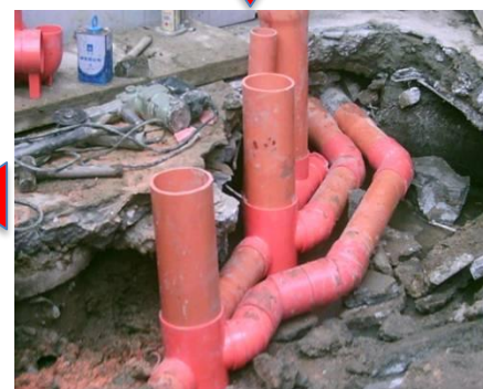
銜接 用戶污水管線
