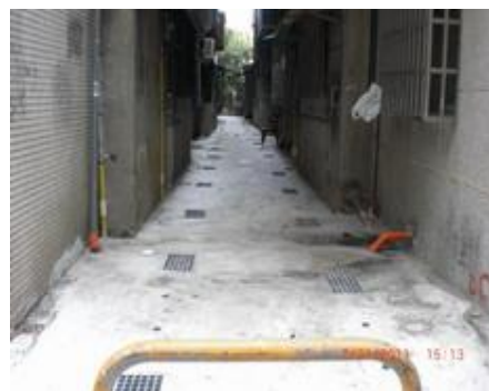
鋪設後巷 混凝土地坪
