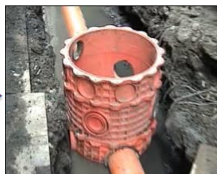
後巷開挖 污水設施埋設
