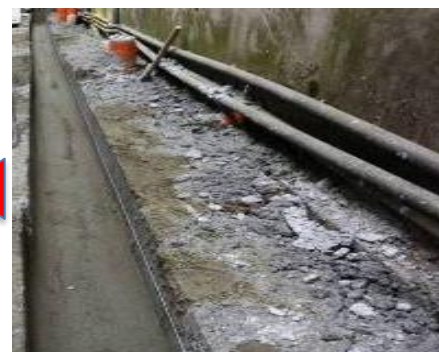
新建 雨水排水溝
