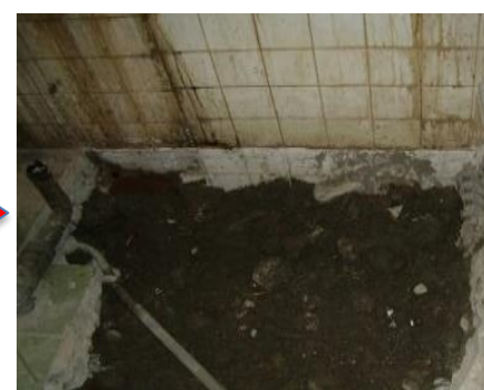
化糞池打除 接管.回填
