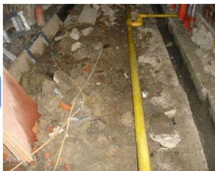
後巷民生管線永遷 (自來水、瓦斯)
